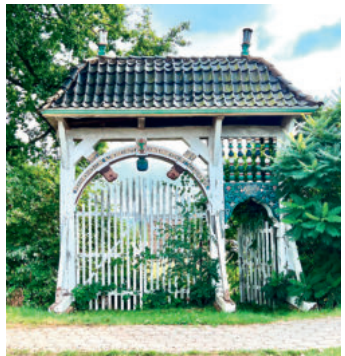
Restaurierung Altländer Prunkpforte
